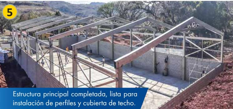
5 Estructura principal completada, lista para instalación de perfiles y cubierta de techo.
